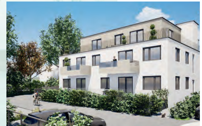
▼ WOHNBEBAUUNG BERNDORF → Nutzfläche: ca. 480 m 2 ; 8 Wohneinheiten. Hybridbau bestehend aus Dichtbetonkeller und Obergeschoßen in Modulbauweise → Status: Vorentwurf
